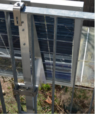
Beispiel: Montagedreieck für offene Geländer
